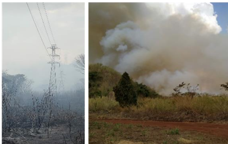
Figura 35 - Registro Fotográfico – Desligamento da LT ARA – FSA
